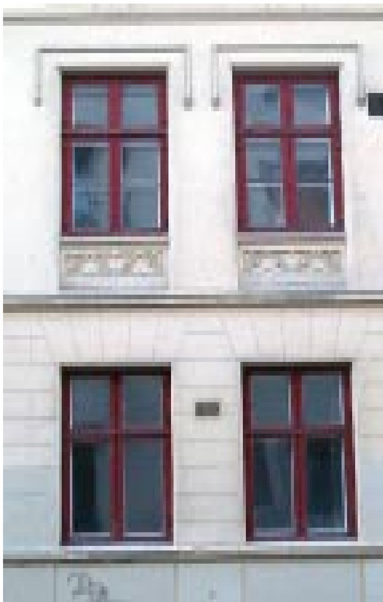
To generasjoners «murgårdsvinduer». Vinduene i 2. etasje er typiske for midten av 1800-tallet. I første etasje sitter den vindustypen som ble vanlig fra 1870-80-tallet.
